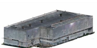
Fig.01. Reconstrução tridimensional do edifício industrial, com recurso a drone e laser scan.
